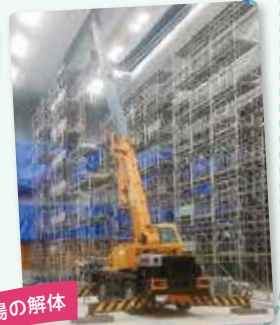
吊物機構の新モーター設置作業
